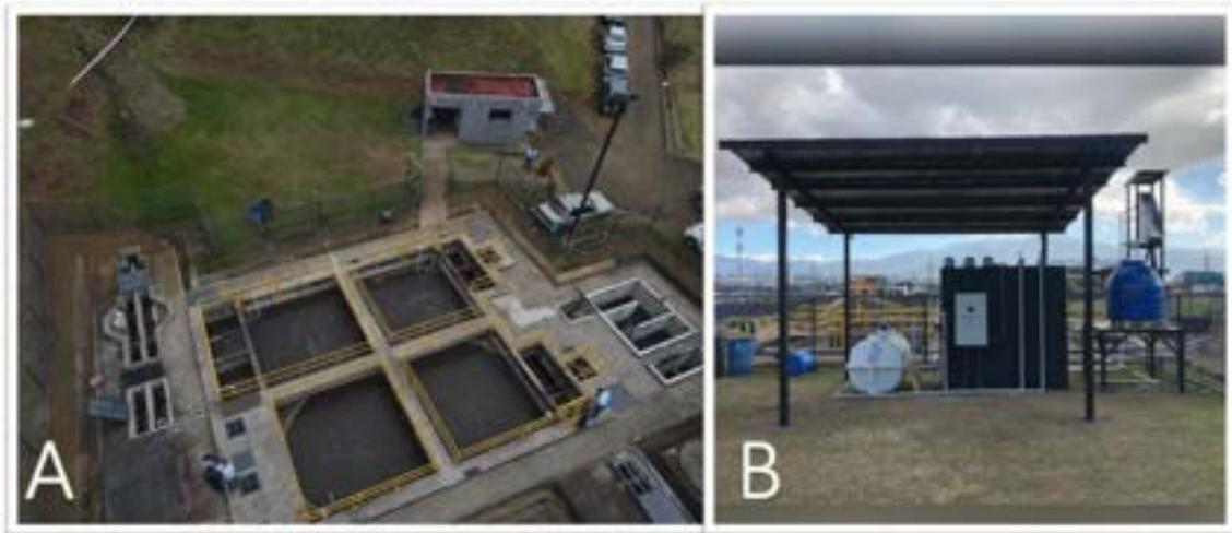
Figura 1. Imágenes del sitio de muestreo: A. Sistema de tratamiento de aguas residuales de lodos activados convencional (Convencional) y B. Sistema piloto de tratamiento de Biorreactor de Membrana (MBR).
