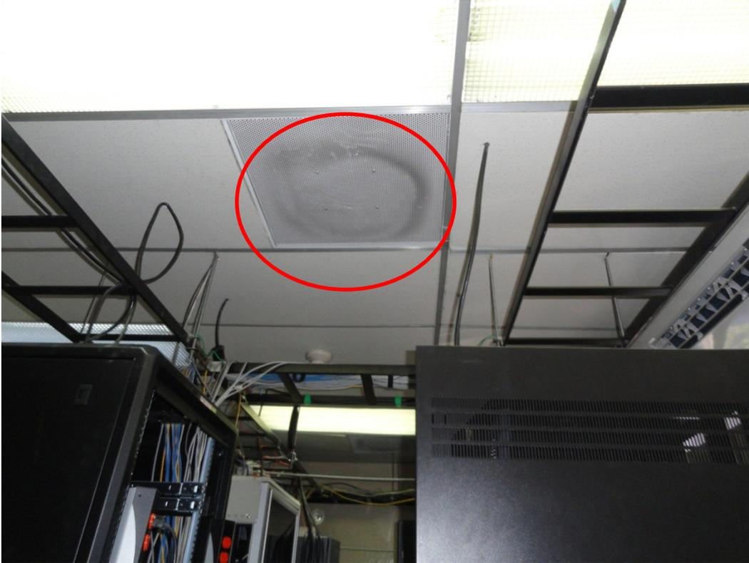
Foto7: Rastros de humedad en el cielorraso sobre servidores "DATA CENTER". 8/03/2011
