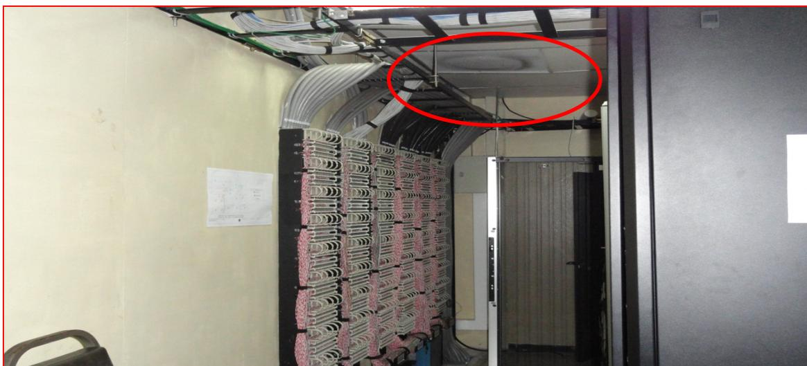
Foto6: Rastros de alguna humedad en el cielorraso sobre cableado "DATA CENTER". 8/03/2011
