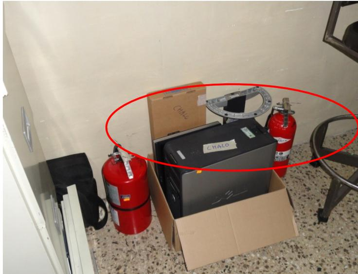
Foto3: Extintores ubicados en mal lugar dentro del “DATA CENTER”.
